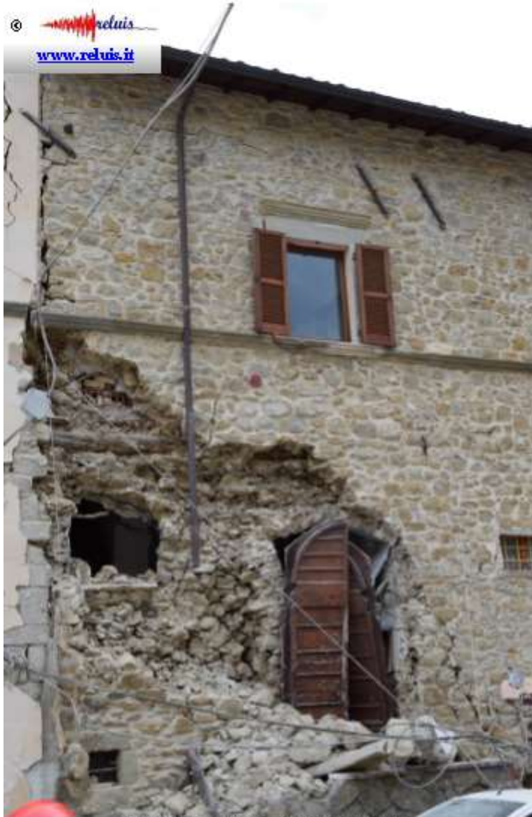
Edificio in muratura – Arquata del Tronto
