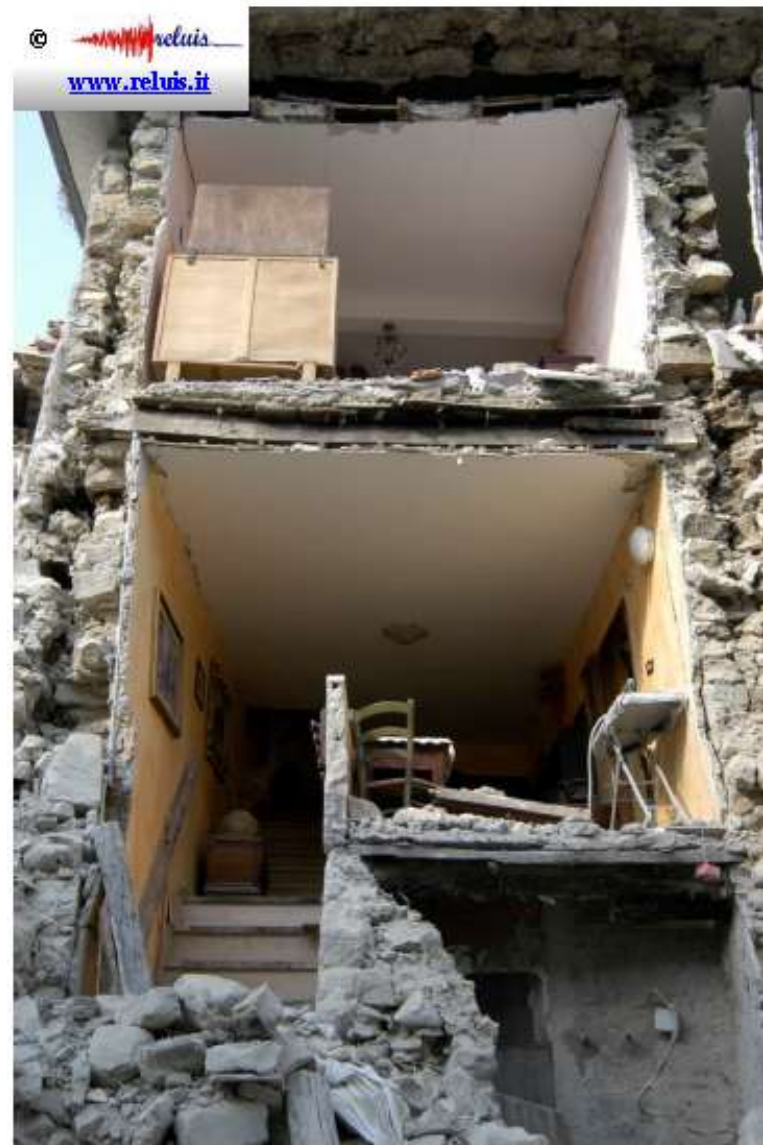
Edificio in muratura - Amatrice parete muraria e messa in luce della sezione trasversale della muratura (doppio para scarsamente armati trasversalmente).
