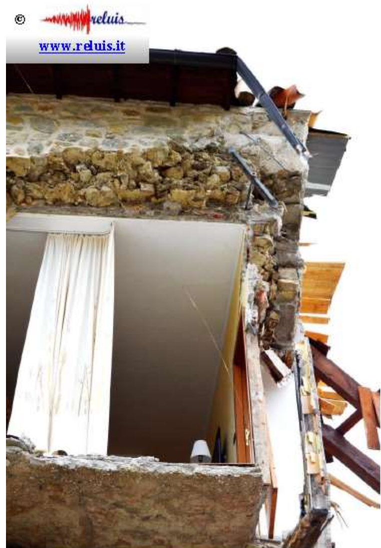
Edificio in muratura – Arquata del Tronto
