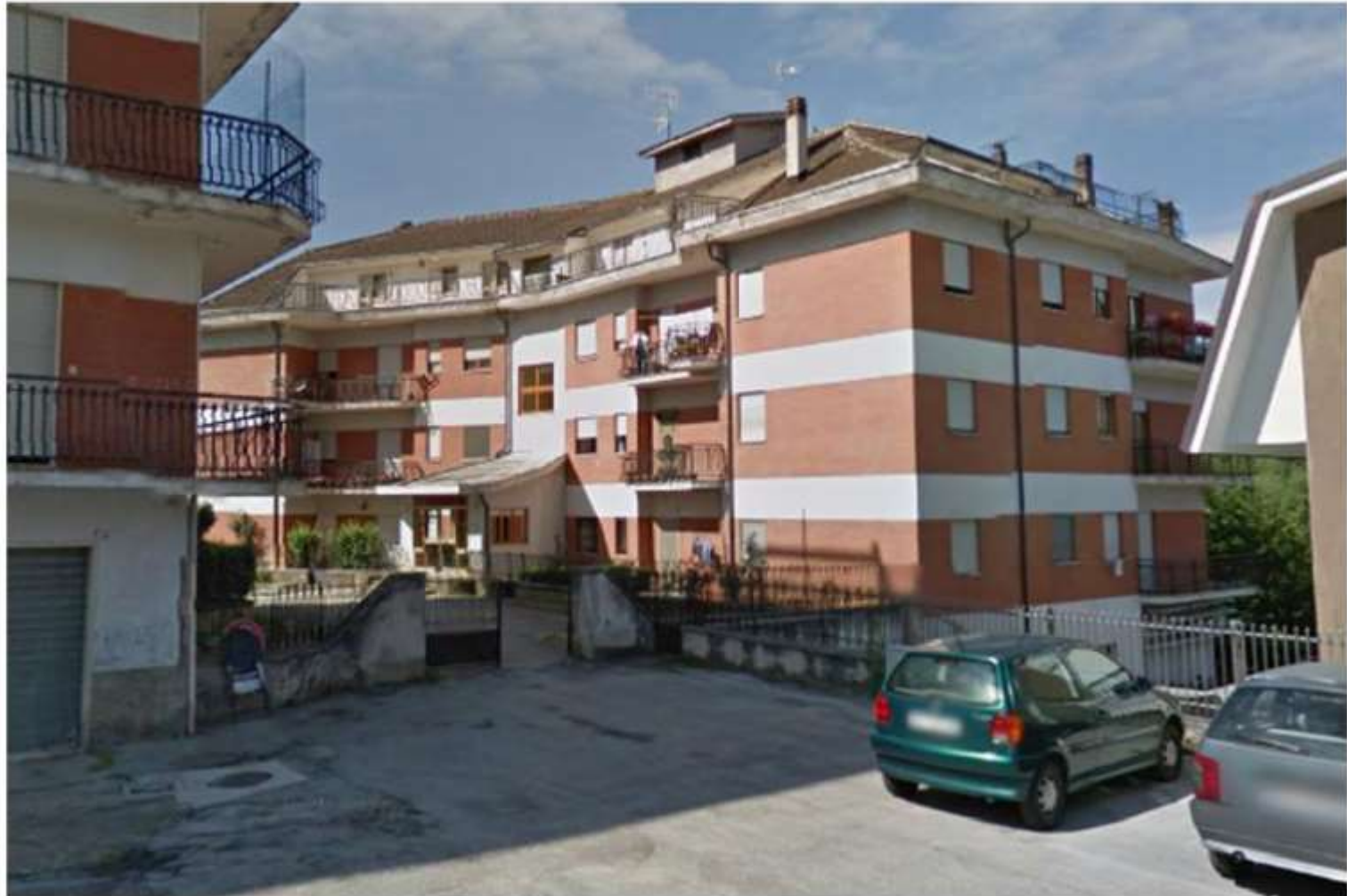
Situazione pre sisma
